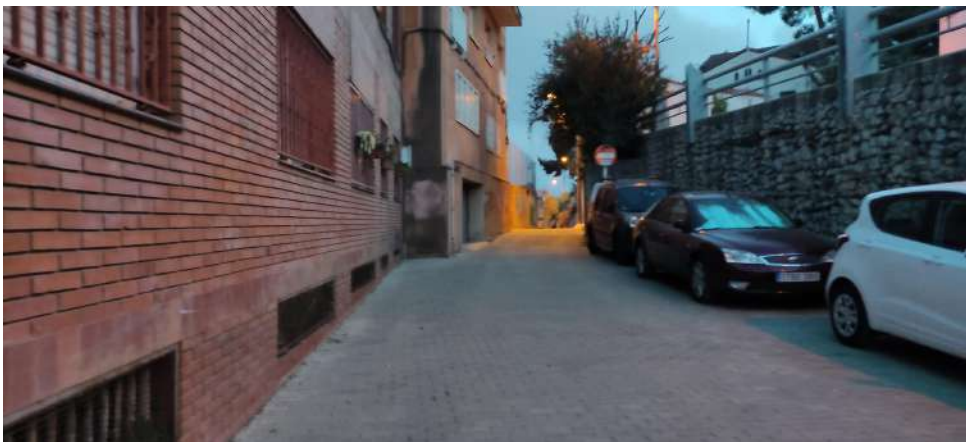
Figura 12. Façanes posteriors dels edificis a C/ Sant Pere Més Alt.
